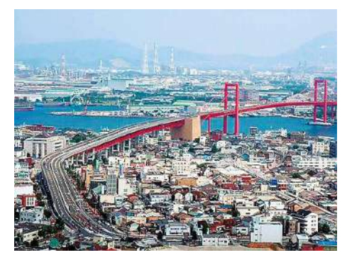
市民の運動で無料化された若戸大橋
